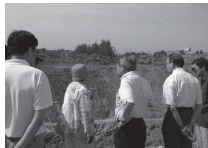
下水管工事現場視察
